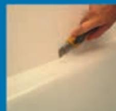
Retirer l'ancien joint silicone : glisser la lame d'un cutter bien à plat entre le mur et l'ancien joint, puis entre la baignoire et l'ancien joint, afin de découper le joint. Veillez à ne pas entailler le revêtement de la baignoire (ou receveur) s'il est en résine.
