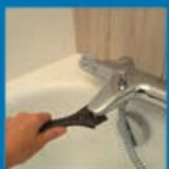
Les mousseurs des mitigeurs doivent être détartrés une ou deux fois par an. Pour cela, vous pouvez les dévisser avec une clé à molette, puis les faire tremper quelques minutes dans un verre avec du vinaigre blanc. Après nettoyage et rinçage, le mousseur sera remis en place et revissé. Serrer très légèrement au remontage. Selon la forme de votre robinet, vous pouvez également suspendre au robinet un petit sachet rempli de vinaigre maintenu par un élastique.
