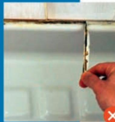
Un défaut d'étanchéité des joints en silicone peut entraîner des infiltrations longtemps invisibles.
