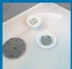
La bonde de la douche est démontable pour l'entretien. Généralement, le capot se démonte en le tournant légèrement. Selon les modèles, un manchon plastique peut alors être ôté de façon à accéder à la canalisation. Toutes les matières présentes, cheveux, savon, doivent être retirées. La canalisation peut être détartrée en versant un mélange de vinaigre blanc (2 verres) et de bicarbonate de soude (1/2 verre). Laisser agir 1 heure puis brosser et rincer.
